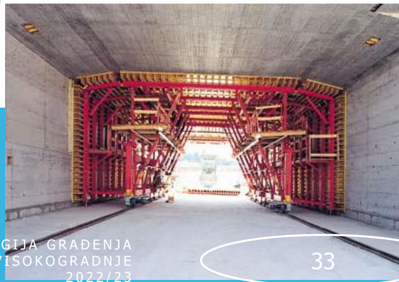
Primjena prenosivih oplata
